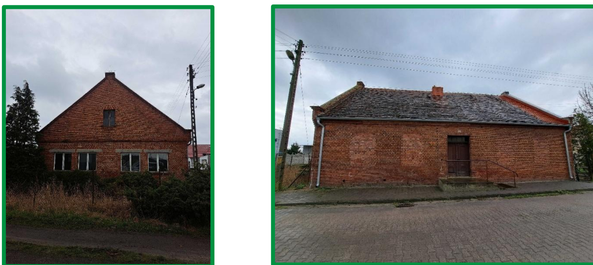
Ryc. 23. Budynek po byłym przedszkolu - Kielpiny 11
